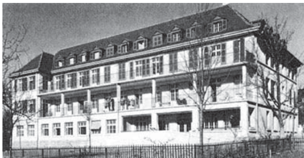
L'Hôpital (Hospice) Orthopédique de la Suisse romande de 1927
